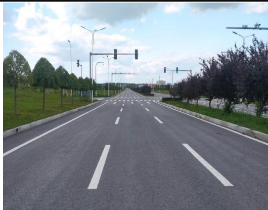
长吉北线交叉路口（照片1）
