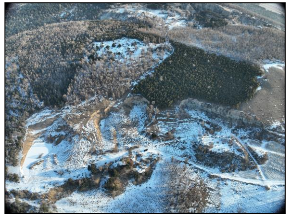
照片 1-4 排土场现状（利用旧采坑）
